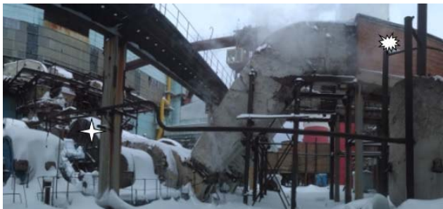
Рис. 1. Существующий газоход котла после одного из дымососов. Звездой показано планируемое место монтажа теплообменника. Крестом показан один из дутьевых вентиляторов котла, к которому подключается вновь монтируемый воздуховод от нового теплообменника.
